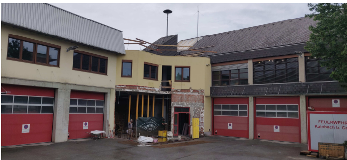
Umbau und Erweiterung im Eingangsbereich Feuerwehr
