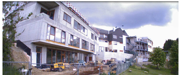
Gartenansicht Rohbau – Mai 2021
