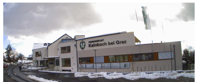
Straßenansicht vor Fertigstellung – Dezember 2021
