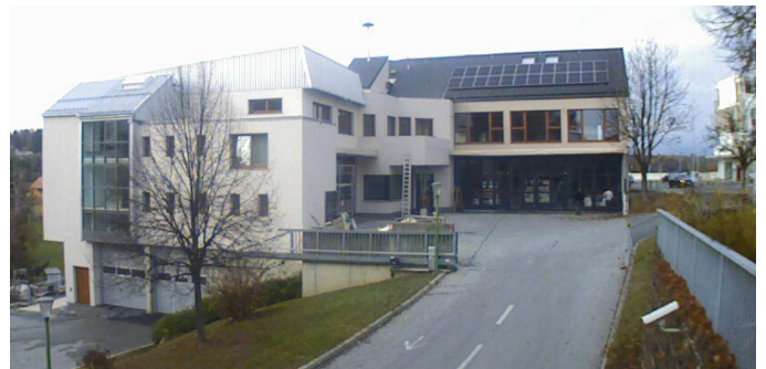
Bauhofansicht vor Fertigstellung – November 2021
