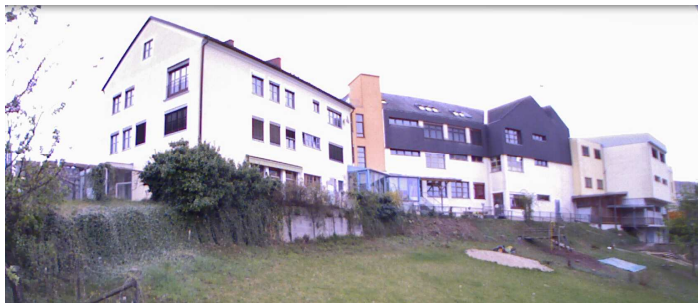
Gartenansicht vor dem Baustart – April 2021
