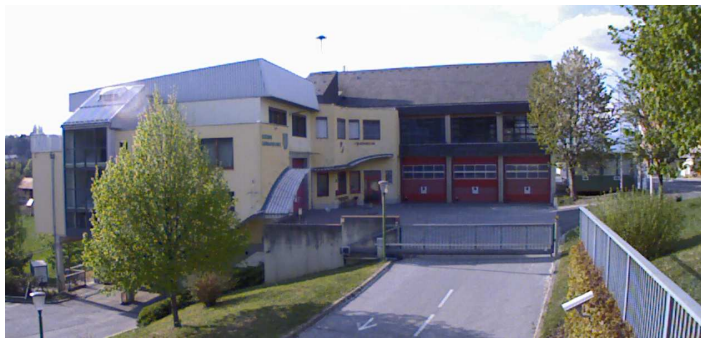
Bauhofansicht vor dem Baustart – April 2020
