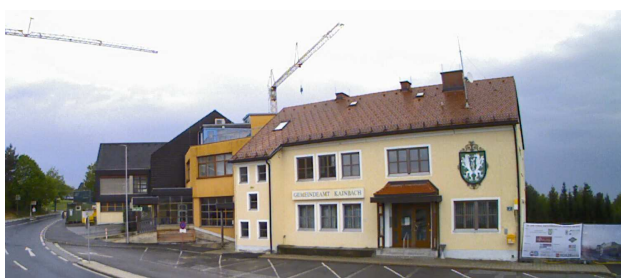
Straßenansicht vor dem Baustart – April 2021
