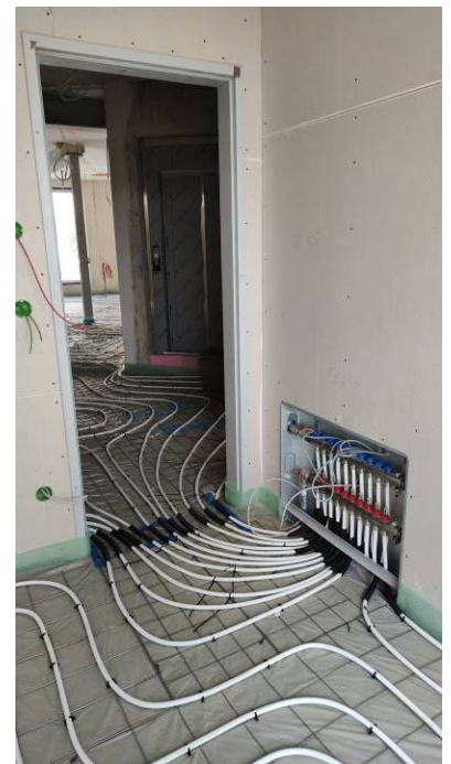
Fußbodenheizung im gesamten Neubaubereich
