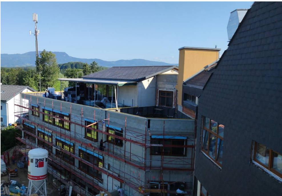
Süd-West Fassade des Kindergartenbereiches wird bereits mit mineralischer Wärmedämmung versehen.
